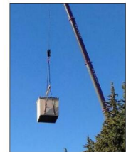
La mise en place du surpresseur raccordé à Duranc Ventoux en 2019.
